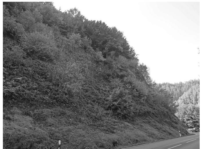
Die B 317 an der „Grendelkurve“ muss für Hangsicherungsmaßnahmen gesperrt werden
