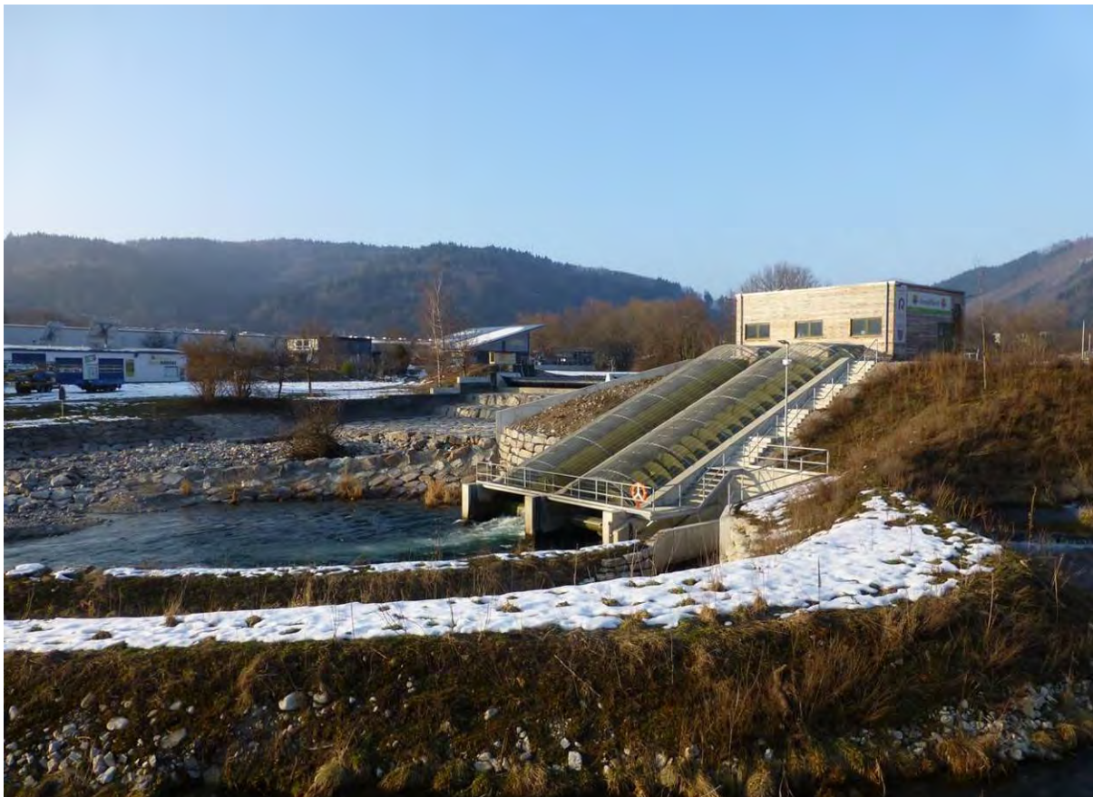
Abbildung 16 Neues Wasserkraftwerk mit Schneckengetriebe und Fischtreppe (Privat)
